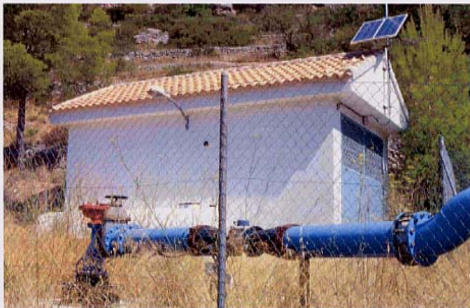
Fotografía n° 1: Detalle del sondeo “Aitana”.
